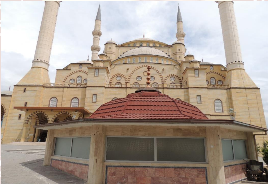
Resim 6: Caminin batı cephesi ve kadınların abdest bölümü
