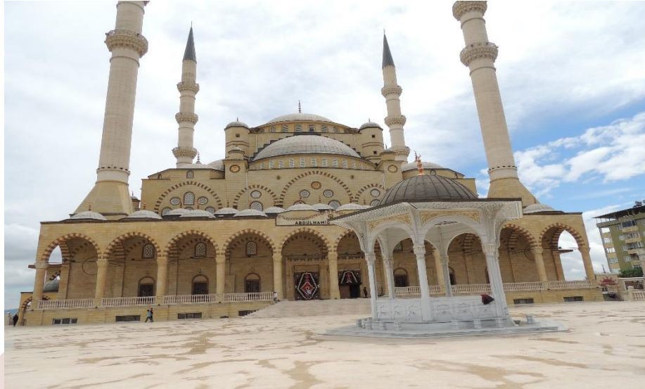
Resim 5: Caminin kuzey cepheden görüntüsü ve revaklı son cemaat yeri ile mermer şadırvanı
