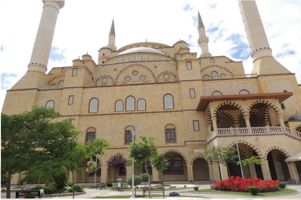
Resim 3: Caminin dođu cephesinden görünümü
